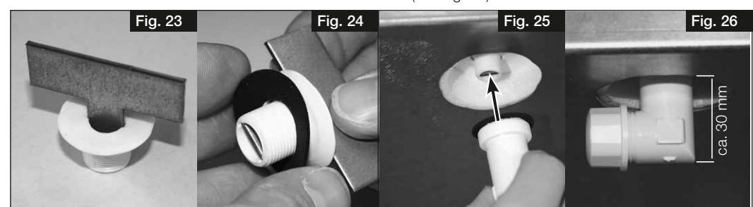
12. Insérer ensuite un tube d'évacuation de condensats de type DN 12 mm (non fourni) sur le tuyau de raccordement du siphon et visser manuellement.
